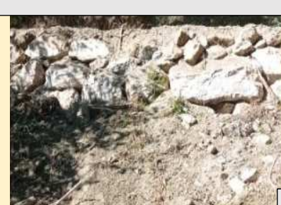
Enrochement sécurisation-Les bordettes
